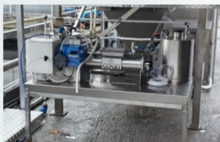
Reattore installato in impianto depurazione
